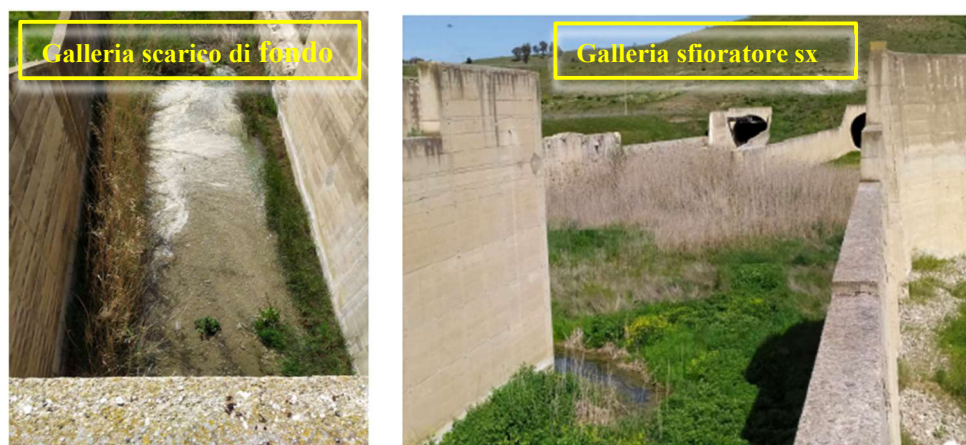
Figura 6-1: Diga di Gibbesi – Galleria scarico di fondo e galleria sfioratore sx - Presenza d'acqua e di alta vegetazione
